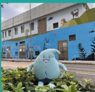
大環 海水抽水站
