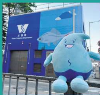
糖水道 食水抽水站
